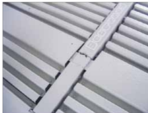
Trapezblechbelag der Plattform
