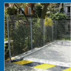
marking pit edge
